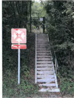
Les portails et portillons d'accès aux voies
